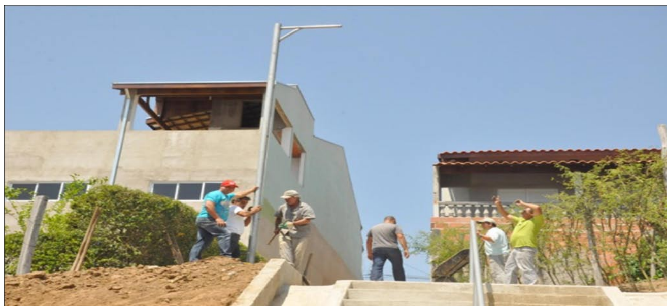
Fonte: Secretaria Municipal de Defesa e Mobilidade Urbana. Instalação de iluminação pública e revitalização da escadaria entre o Residencial Nova Caçapava e o Residencial Vitória Vale.
