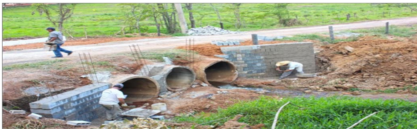
Fonte: Secretaria Municipal de Defesa e Mobilidade Urbana. Cabeceiras da ponte na estrada do Teixeira.
