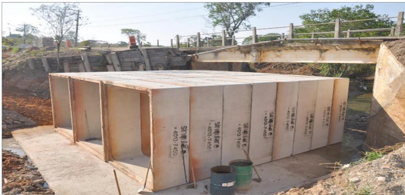
Fonte: Secretaria Municipal de Defesa e Mobilidade Urbana. Construção de cabeceiras da Ponte sob o Ribeirão da Cachoeira, na estrada Amadeu Tenedini (ligação entre Caçapava Velha e Vila Velha I e II).
