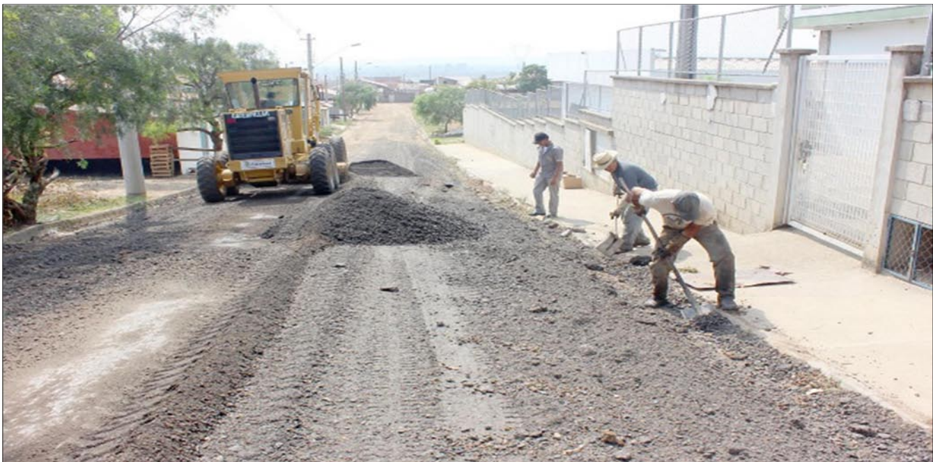
Fonte: Secretaria Municipal de Defesa e Mobilidade Urbana. Recapeamento de vários trechos da Rua Benedita Augusta de Paula, no Bairro Aldeias da Serra (Bairro Tataúba).
