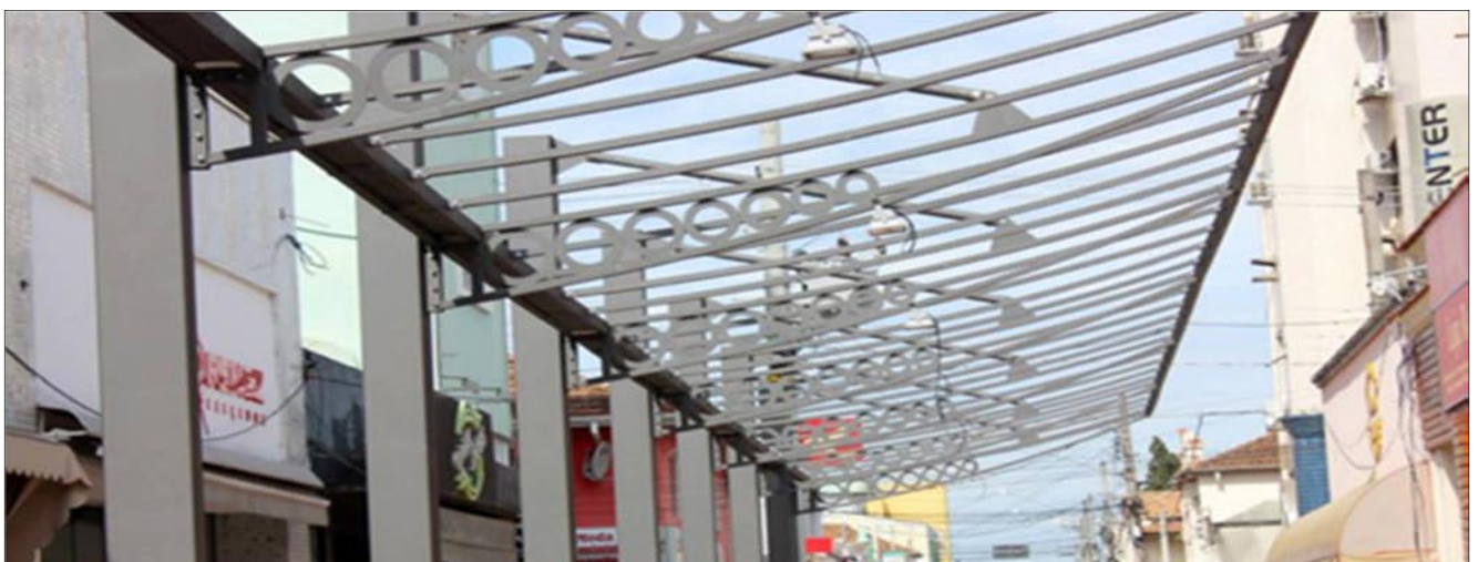
Fonte: Secretaria Municipal de Defesa e Mobilidade Urbana. Fotos após reabilitação.
