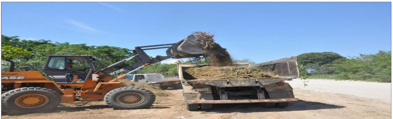
Fonte: Secretaria Municipal de Defesa e Mobilidade Urbana. Cabeceiras da ponte na estrada do Teixeira.
