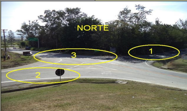
FOTO GERAL LADO NORTE:
